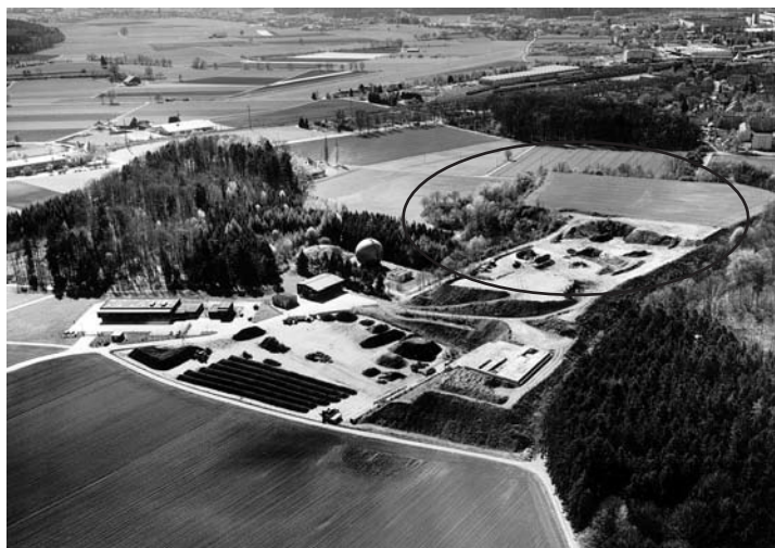
Fig. 2: Gesamtansicht der Deponie Riet, Winterthur. Der alte, rekultivierte Deponie teil („Stinkberg“, Markierung rechts im Hintergrund), verfügt über keine Basisabdichtung (Foto: Departement Bau, Stadt Winterthur).
